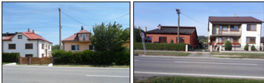
Domy s manzardami z druhej etapy – dnes zmodernizované Zmodernizované zateplené domy popri ceste I/15
